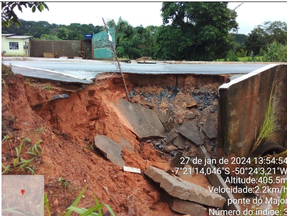
Foto: 01 bueiro com dados significativos pela força da enxurrada
