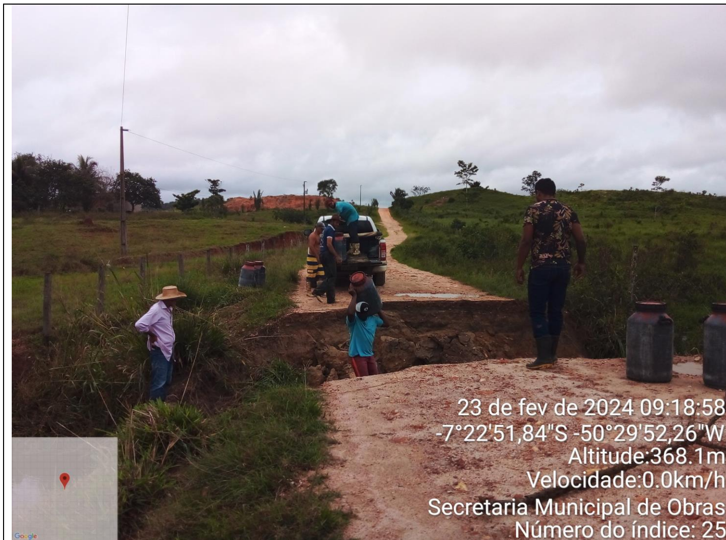
Foto: 04: destruição de linha bueiro, produtores rurais fazendo transbordo de produção leiteira para poder escoar
