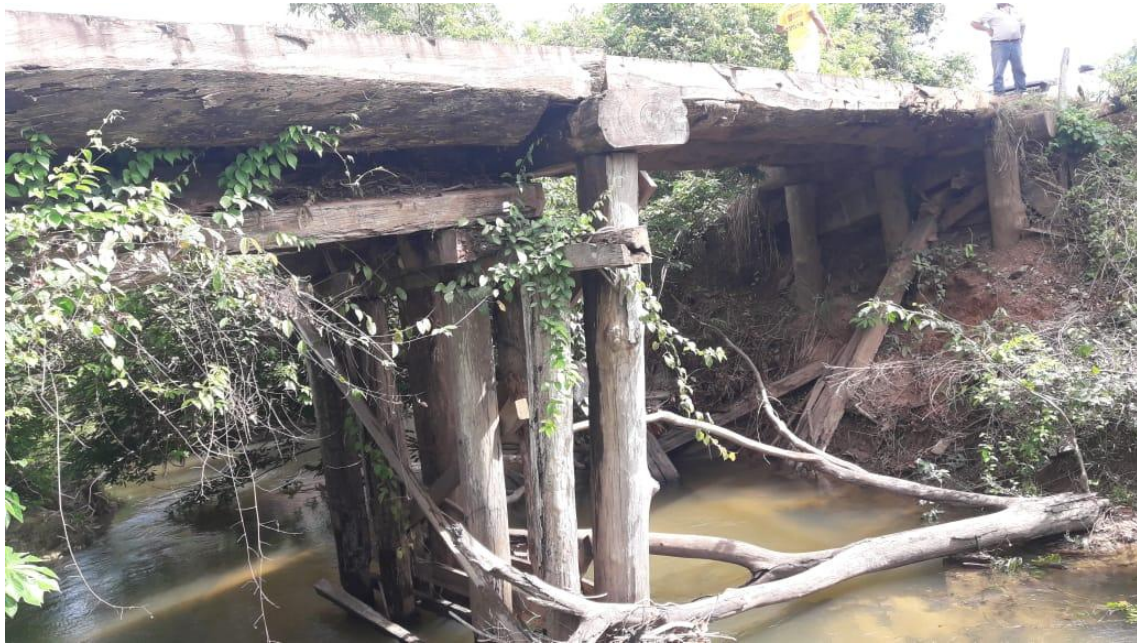
Figura 3 - Ponte sobre o Rio Jatobá, 7°15'3.40"S/ 50°35'33.10"O.
