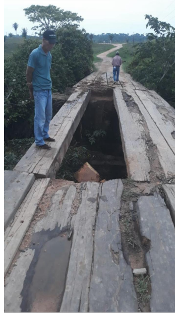
Figura 2 - Ponte sobre o Rio Jatobá, 7°15'3.40"S/ 50°35'33.10"O.
