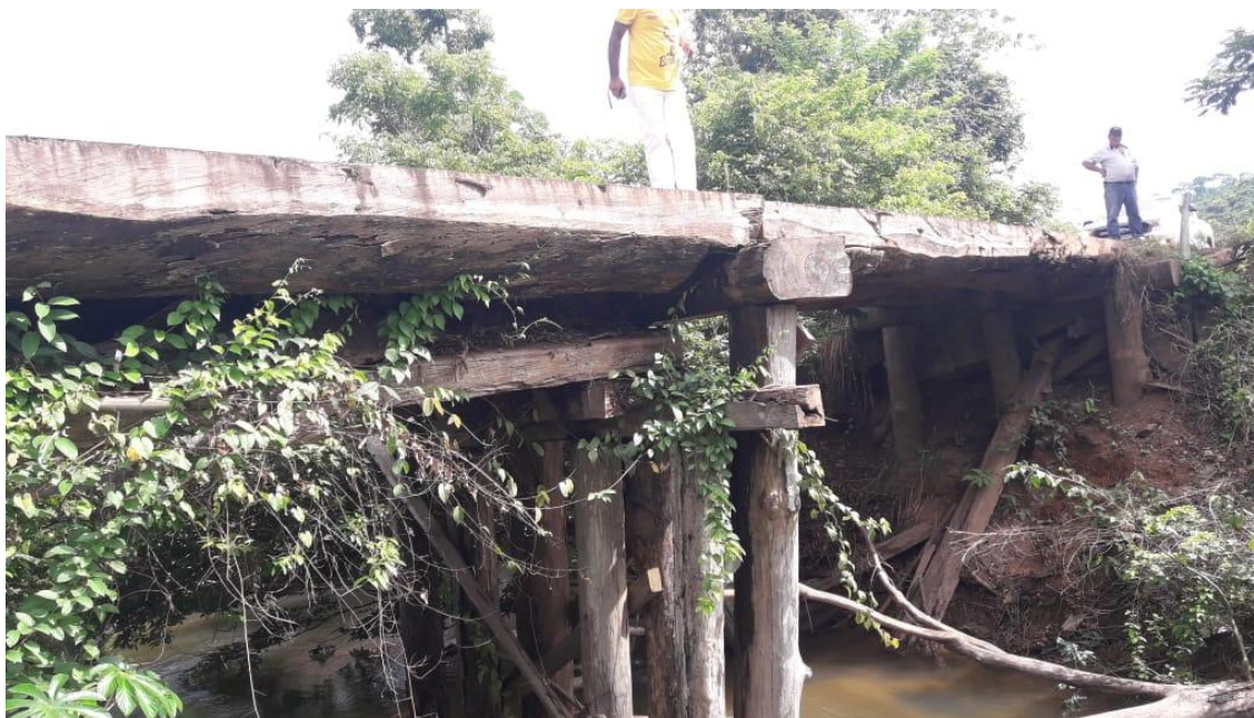
Figura 1- Ponte sobre o Rio Jatobá, 7°15'3.40"S/ 50°35'33.10"O.
