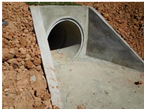
Foto 07: ALA DE BUEIRO.
