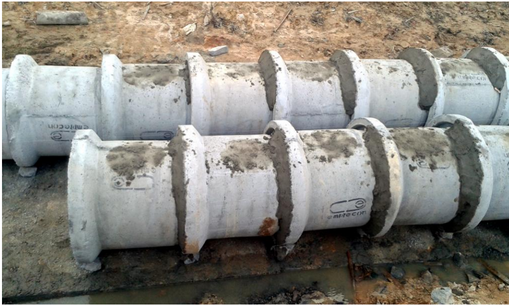
Foto 06: TUBOS DE CONCRETO ARMADO MONTADOS.
