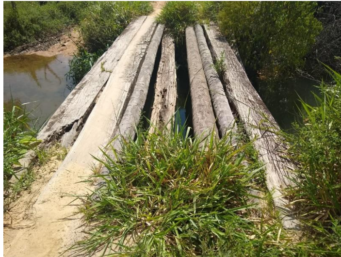
Foto 02: Ponte do Bananal.
