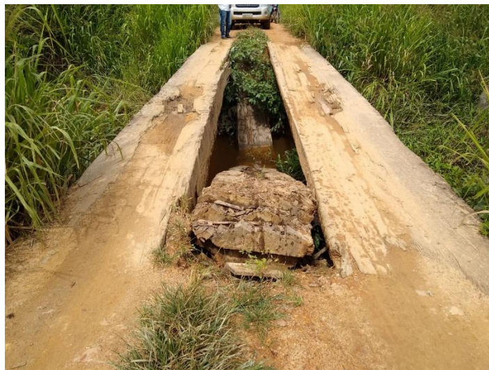
Foto 04: Ponte da Serra.
