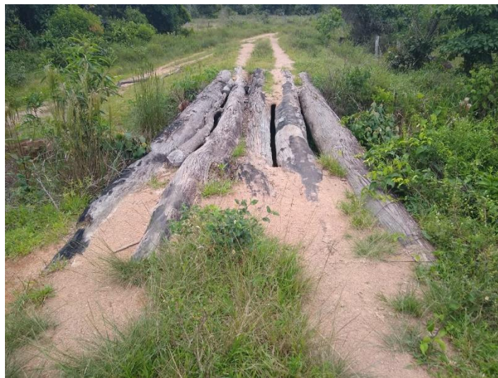
Foto 09: Ponte faz. 5 irmãos.
